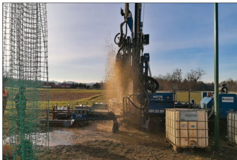
Komunalno podjetje Ptuj je ob draženskem gasilskem domu pristopilo k izgradnji globinskega vodnjaka. Foto: arhiv občinske uprave
