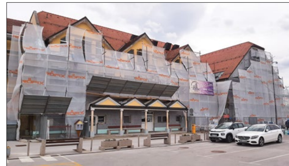
Na zgradbi OŠ Hajdina poteka energetska sanacija po predvidenem terminskem načrtu.
